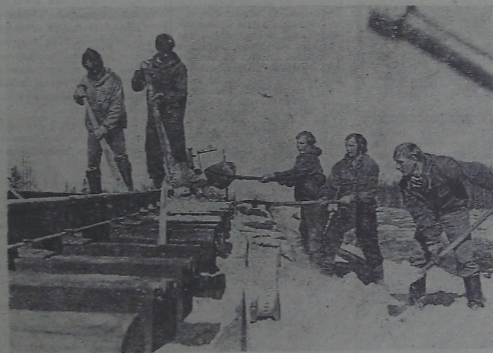
Все ближе к Уренгю поднимается укладка железнодорожного полотна Сургут — Уренгой. Бригады путеукладчиков СМП-565 приближаются к финишу передачи эстафеты укладки пути СМП-522. Примечательно, что на финише укладки СМП-565 готовится выполнить план завершающего года пятилетки.
