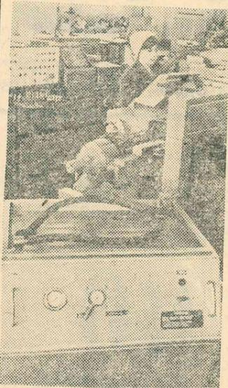
В Саратовском электроагрегатном производственном объединении созданы стенды для тонкой очистки отработанных масел, гидравлических и промывочных жидкостей. Эта установка дает вторую жизнь различным маслам и гидроэмульсиям в станках, машинах, экскаваторах, самолетах. С помощью передвижного стенда старое масло, которое раньше просто выливали, очищается и вновь попадает в агрегат.
