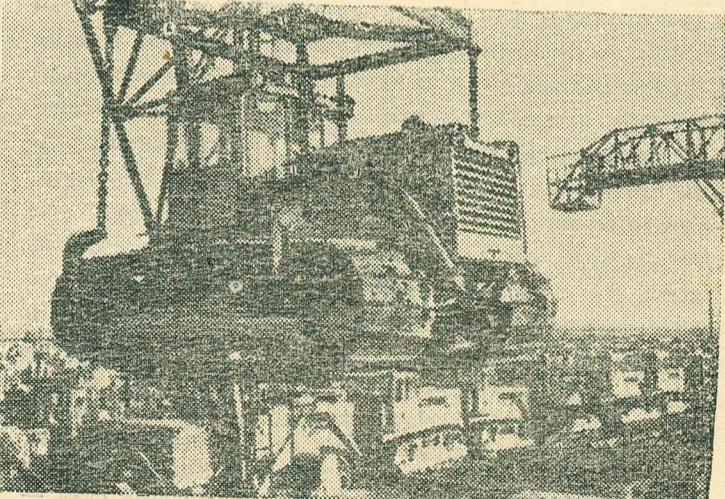
Челябинск. На мелиоративных работах в Нечерноземье хорошо зарекомендовали себя болотоходные тракторы «Т-130 Б», которые выпускает Челябинский тракторный завод. Созданные на базе этой машины трубоукладчики успешно используются и на строительстве нефте- и газопроводов.
