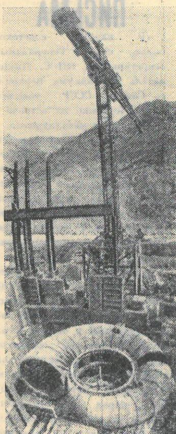
ТАДЖИКСКАЯ ССР. Используя метод укрупненной сборки, завершила монтаж спиральной камеры первого агрегата Байпазинской ГЭС, сооружаемой на Вахше, передовая бригада лауреата Государственной премии СССР А. М. Шильникова. Сделан еще один шаг к пуску электрической машины мощностью 150 тысяч киловатт. Монтажники приступили к следующему этапу — сборке рабочего колеса и вала турбины. Напряженно работают строители и на других участках. Начата укладка бетона в основание второго агрегата станции.
