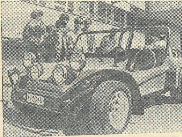
Венгрия. Вот такую необычную машину сконструировал и сделал своими руками житель Кечкемета Иштван Секереш. Под этим современным пластмассовым корпусом, установленным на раме старенького «Фольксвагена», бьется стальное сердце автомобиля-ветерана.
