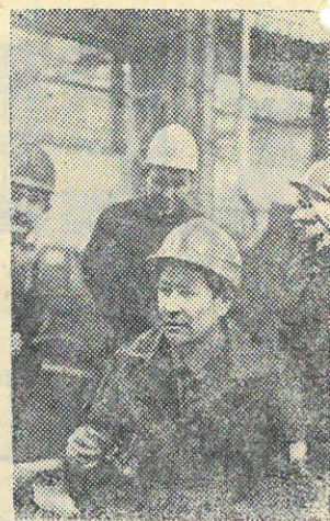
СВЕРДЛОВСК. Бригадира слесарей-сборщиков металлоконструкций, казалаера орден Октябрьской Революции и Трудового Красного Знамени Г. Г. Пальшина на Уралмаше знают как новатора производства.
