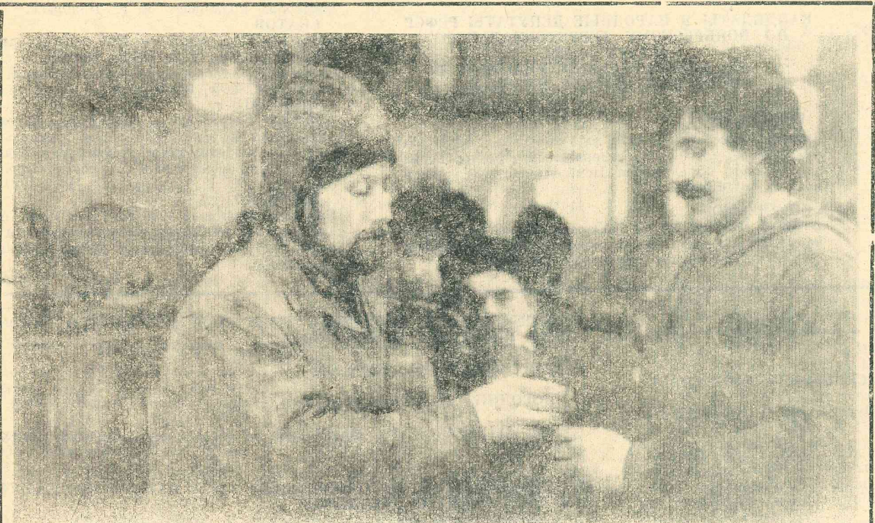
Николай Бирюков работает бригадиром слесарей-ремонтников Южно-Таркосалинской НГРЭ. Ремонт бурового оборудования, возглавляемая им бригада, ведет качественно и с опережением графика. Николай награжден дипломом «Лучший по
