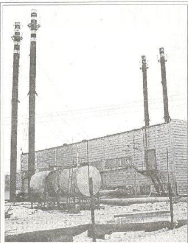
В котельной №4 идут завершающие работы
