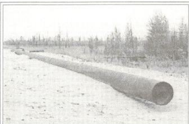
Новая нить водовода
