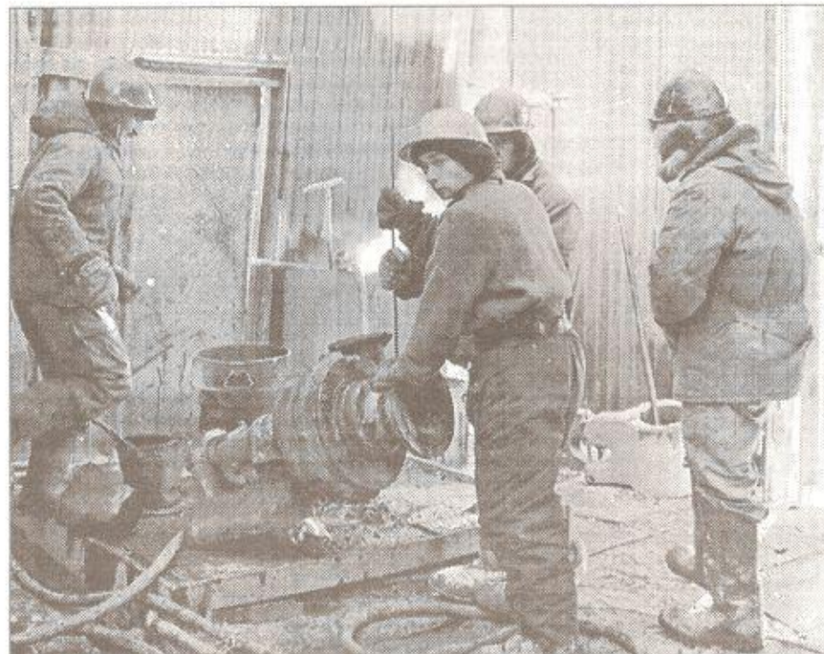
Идет монтаж противовибросового оборудования в бригаде бурового мастера НГРЭ В. Коршукова
