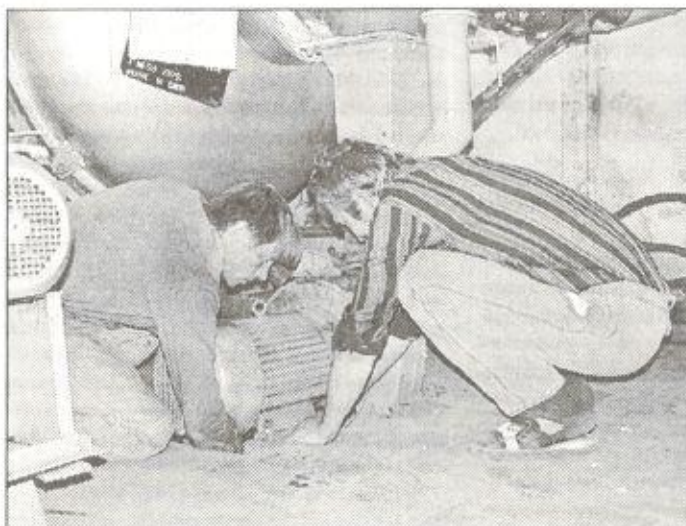
Слесари-ремонтники Сергей Тупиков и Павел Применко заняты монтажом вентилятора
