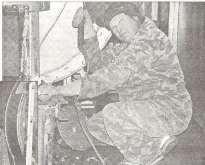
Сварщик Владимир Поляков монтирует котел после капремонта
