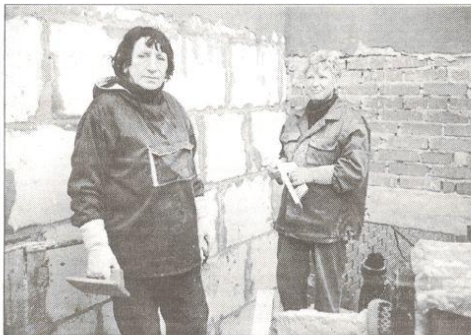
Отделочницы Антонина Брызгалова и Любовь Теленина работают на строительстве нового водозабора
