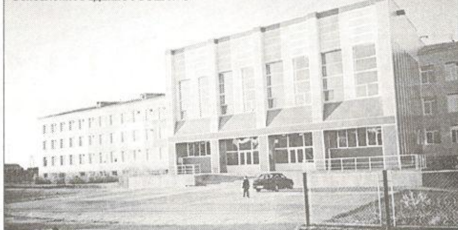
Обновленное здание УСОШ № 3
