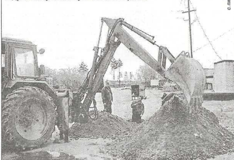
Специалисты цеха № 2 ведут замену ветхого участка теплотрассы
