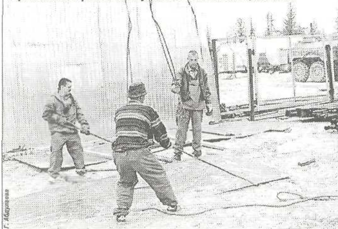
Стропальные работы на участке комплектации ВЖК
