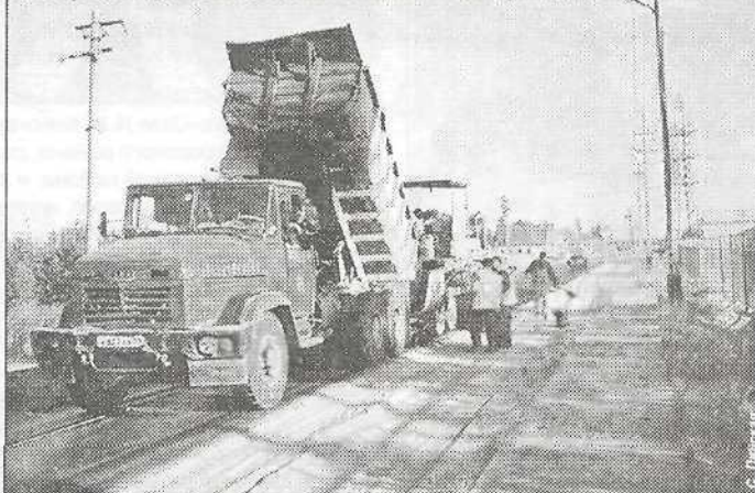
Работы по асфальтированию ул. Есенина уже завершены, а выполнены они были за три дня
