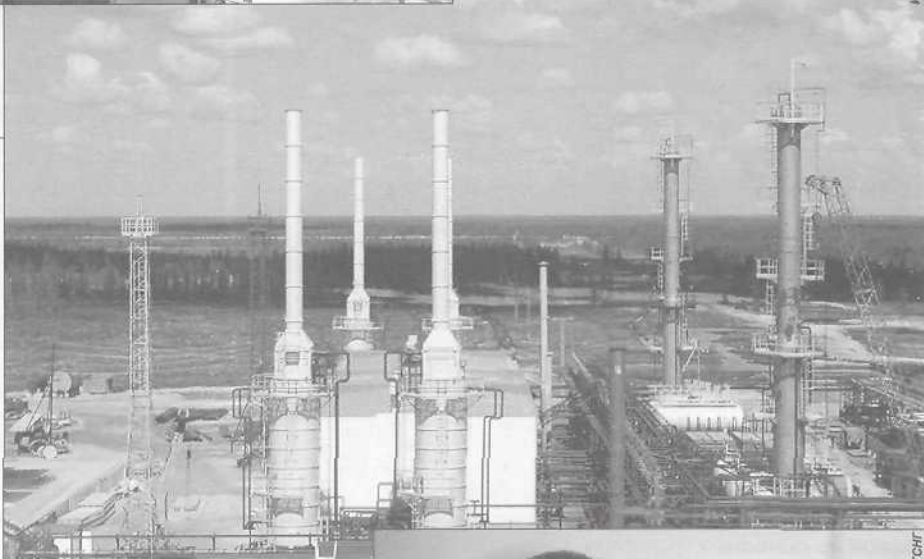
Газоконденсатный промысел. Новый объект компании - установка деэтаннизации конденсата
