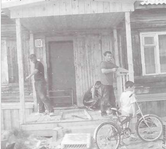
Идет ремонт дома по ул. Строителей
