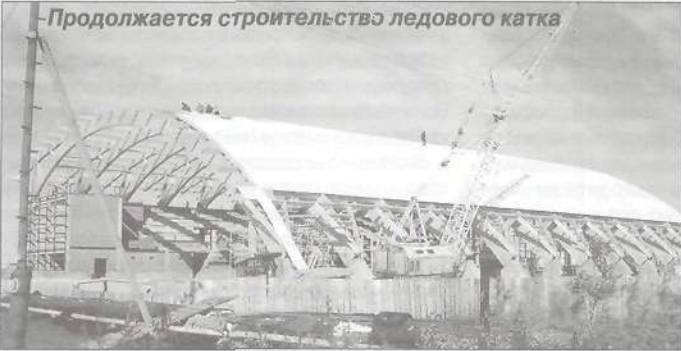
Продолжается строительство ледового катка
