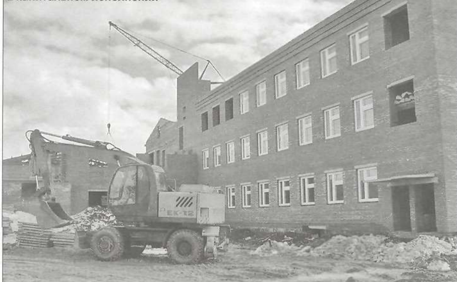
Ведется строительство школы в капитальном исполнении
