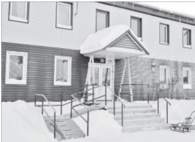
Обновленное после капитального ремонта здание уренгойского отделения дневного пребывания
