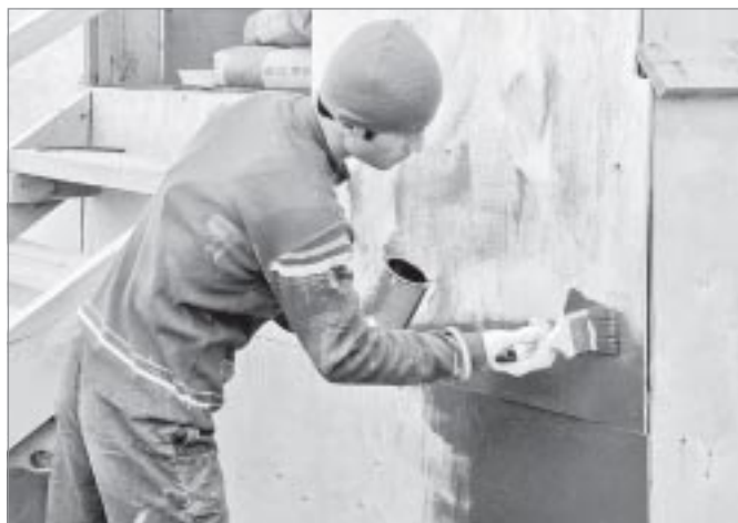
Текущий ремонт жилого дома
