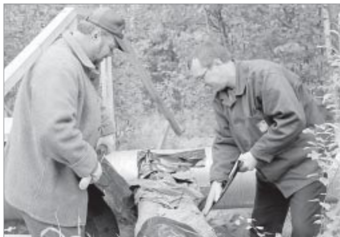
Замена утеплительного слоя теплотрассы
