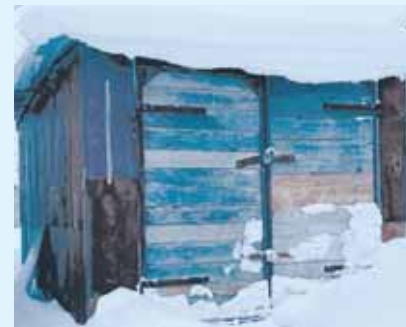
Объект №2 - металлический балок (реестровый номер: объект №46)
