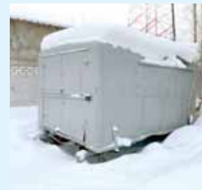
Объект №1 - металлический балок (реестровый номер: объект №47)
