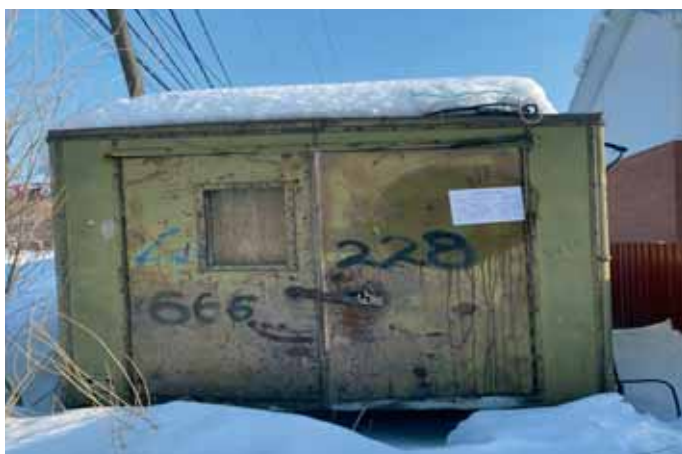
Объект №1 - металлический балок (реестровый номер: объект №50)
