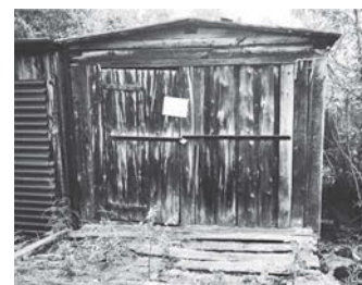
Деревянный гараж (реестровый номер: объект №120)
