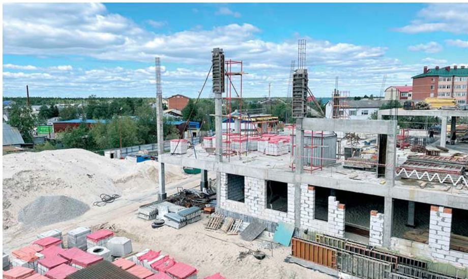
Строительство школы №4 в г.Тарко-Сале
