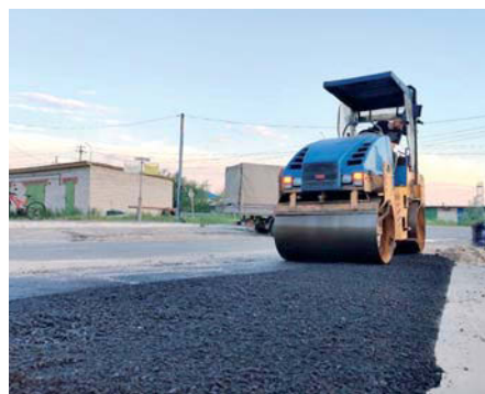
Ремонт дорог в Пуровском районе
