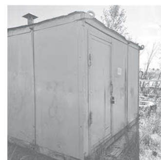
Металлический балок (реестровый номер: объект №16)
