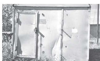
Металлический балок (реестровый номер: объект №7)
