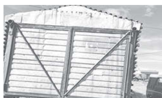
Металлический балок (реестровый номер: объект №5)
